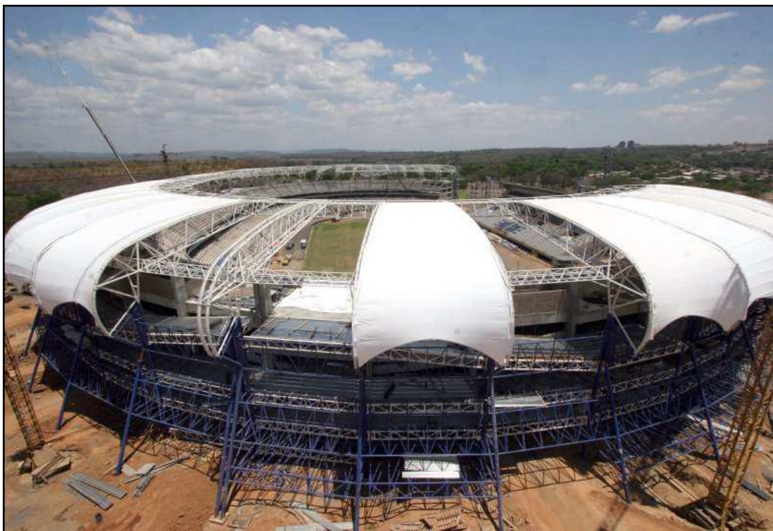
Instalación de la lona en la estructura del techo. Fuente: Bladimir Cova
