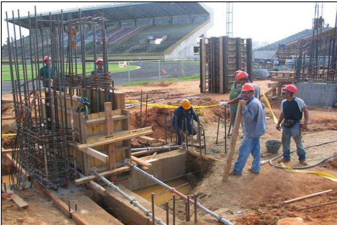
Encofrado de la tribuna lateral oeste. Fuente: Bladimir Cova
