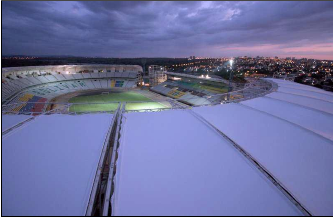
Instalación de la lona en el techo, culminada. Fuente: Bladimir Cova
