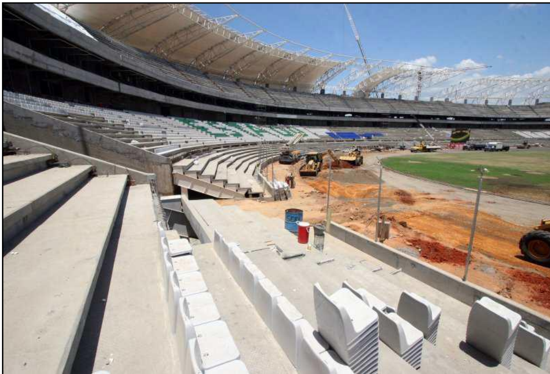
Instalación de las sillas. Fuente: Bladimir Cova
