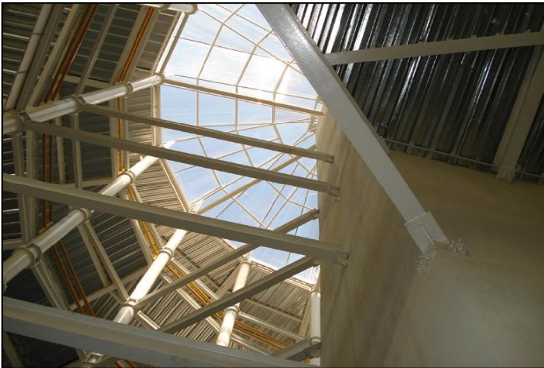
Interior de uno de los cilindros de acceso, parte superior (techo)
