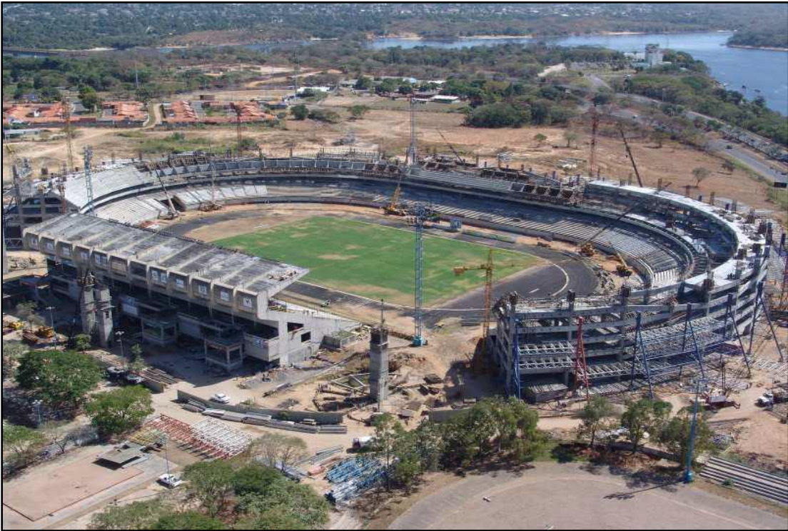
Última fase de construcción. Fuente: Bladimir Cova
