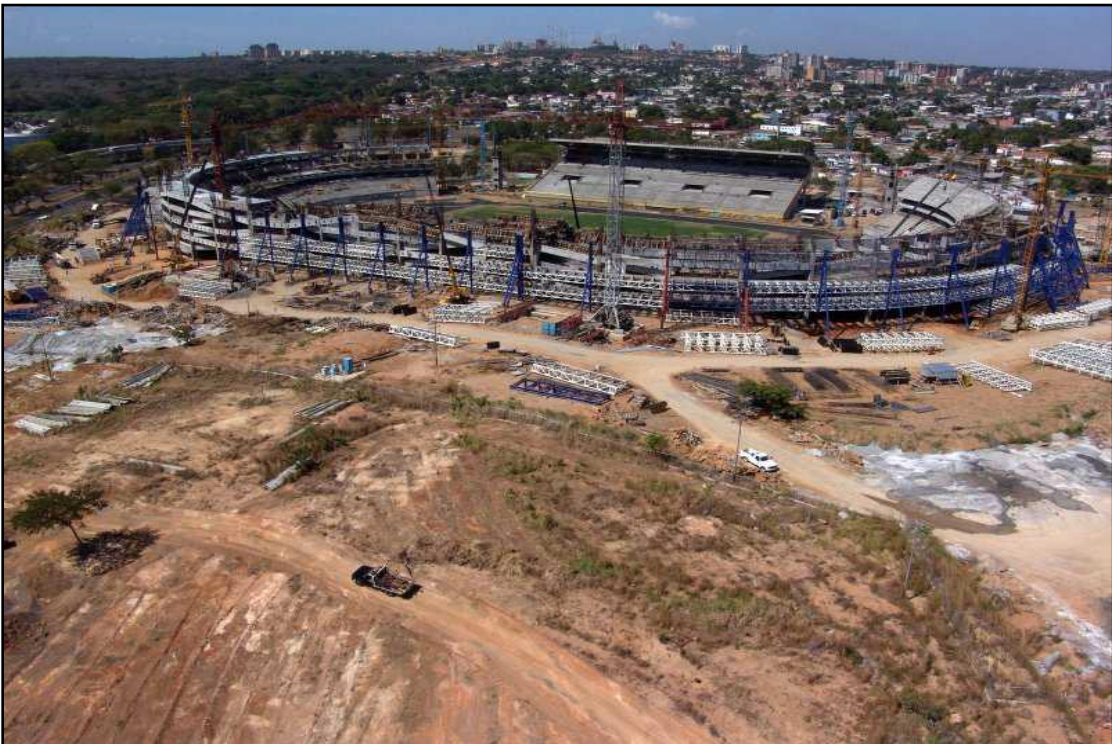
Última fase de construcción, desde otro ángulo. Fuente: Bladimir Cova
