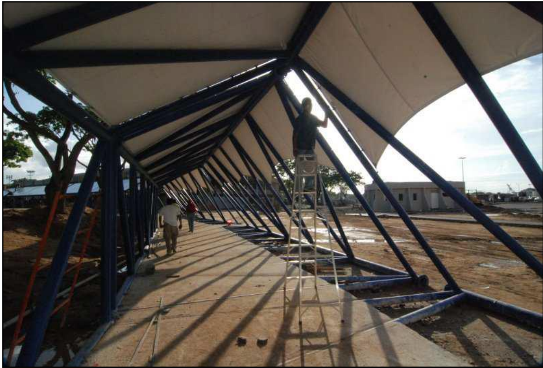
Instalación del techo en las caminerías que conducen al C.T.E Cachamay. Fuente: Bladimir Cova
