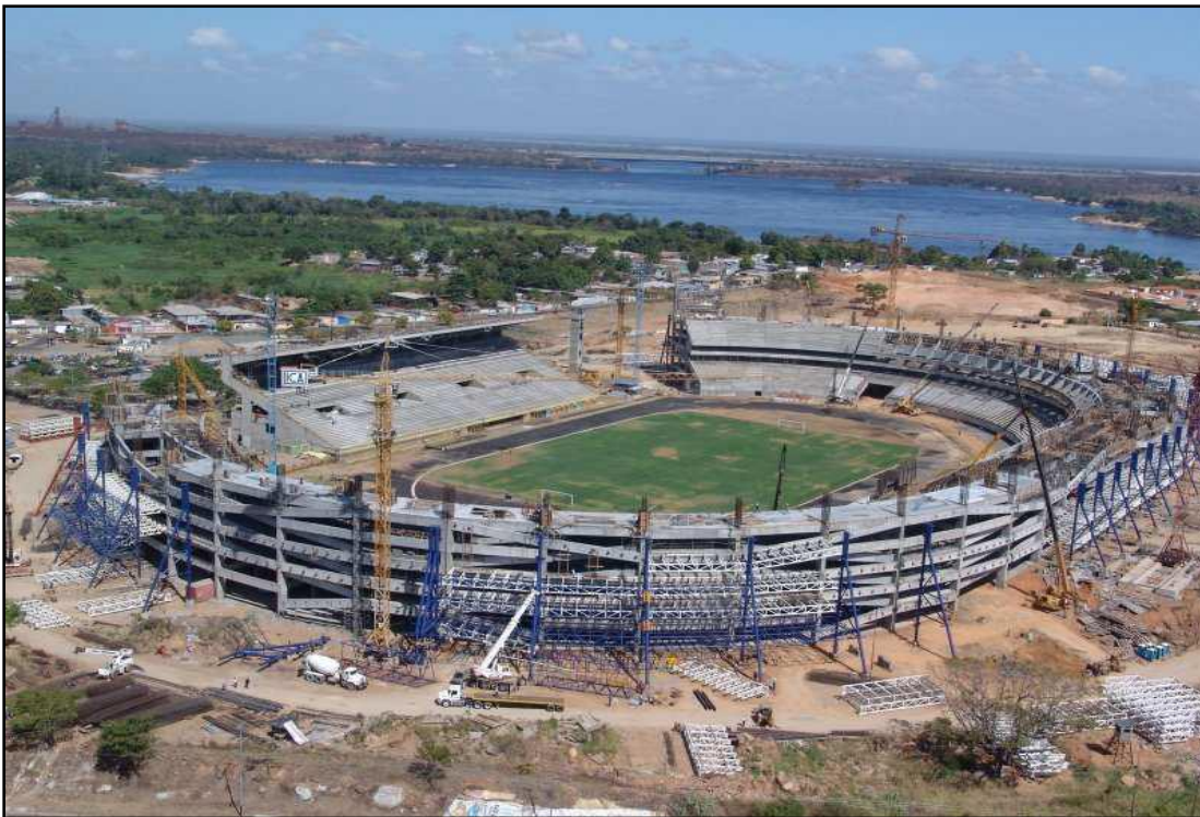
Instalación de pilares para el techo. Fuente: Bladimir Cova
